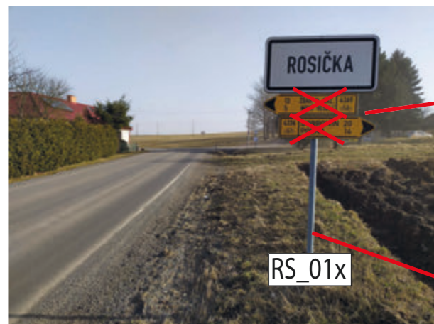
DEMONTÁŽ ZNAČENÍ IS19b (4369) A IS19c (4336) A JEHO NOVÁ MONTÁŽ NA NOVÝ SLOUPEK RS_01
