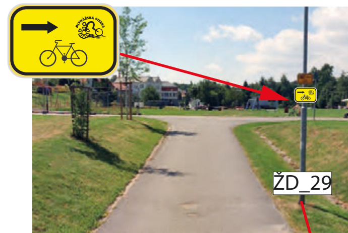
INSTALACE IS21c (MLYNÁŘSKÁ) NA SLOUP VĚREJNÉHO OSVĚTLENÍ POD STÁVAJÍCÍ IS21b (5061)
