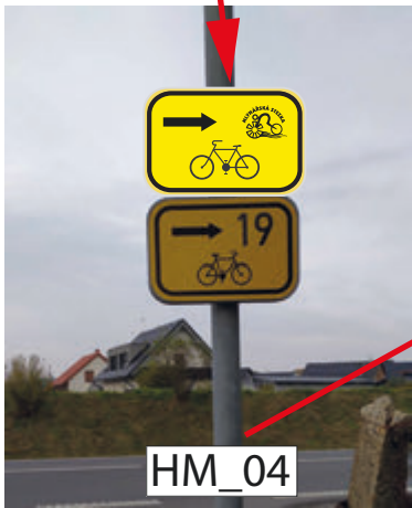
INSTALACE IS21c (MLYNÁŘSKÁ) NA STÁVAJÍCÍ SLOUPEK NAD STÁVAJÍCÍ IS21c (19)
