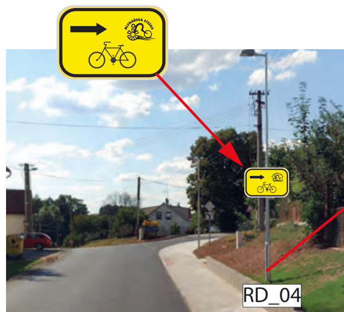
INSTALACE IS21c (MLYNÁŘSKÁ) NA SLOUP VEŘEJNÉHO OSVĚTLENÍ
